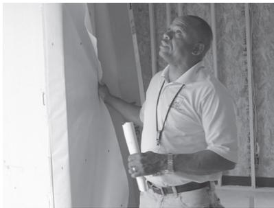
Un técnico líder de Servicios Residenciales de MLGW inspecciona en una casa al norte de la ciudad las instalaciones de eficiencia energética, como este aislamiento de espuma de poliestireno, que envuelve las paredes exteriores de la edificación ayudando a evitar la pérdida de aire, una causa principal del desperdicio de energía.
